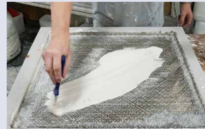
Für die Laminierung müssen Sie Nass-auf-Nass arbeiten. Mit einer Bürste oder einem Farbröller können Sie das A1 sehr zügig auftragen.
