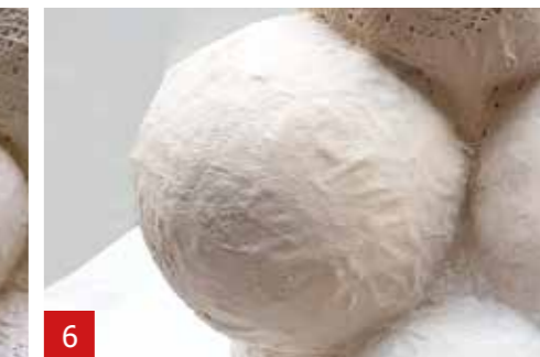
Für eine noch glattere Oberfläche können Sie eine zweite Schicht Glasvlies anbringen.
