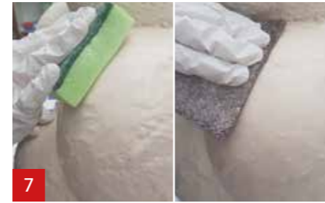
Sie können die Oberfläche (nach ±20 Minuten) auch mit einem feuchten Schwamm oder mit wasserfestem Sandpapier bearbeiten.
