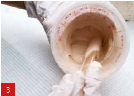
Mischen Sie A1 Flüssigkeit, Thix A und A1 Pulver solange, bis eine geschmeidige Masse entstanden ist.
