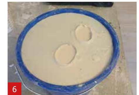
6 Lassen Sie die A1 Masse ungefähr 1 Stunde trocknen.
