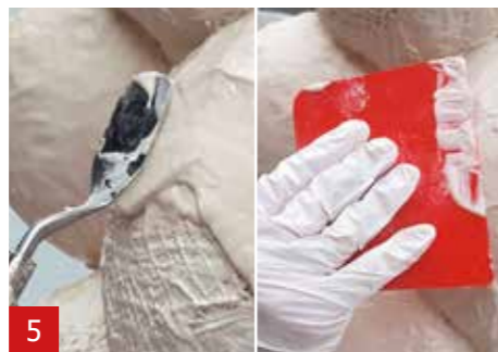
Sie können die A1 Masse mit einer Bürste, einem Farbroller, einer Spachtel oder einer Rakel auftragen.
