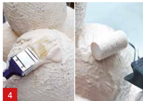
Sie können die A1 Masse mit einer Bürste, einem Farbroller, einer Spachtel oder einer Rakel auftragen.
